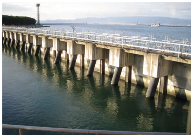
写真-3 発電所の取水口
