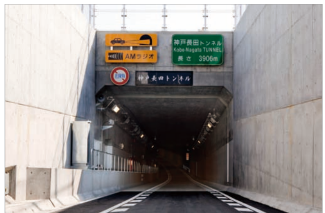
写真-5 神戸長田トンネル坑口
