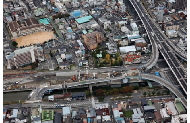
写真-3 湊川ジャンクション改築工事状況 (提供: 大阪建設工業新聞社)
