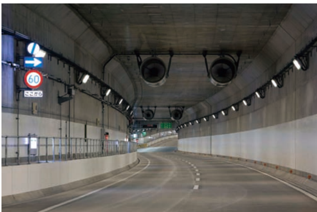
写真-4 神戸山手線本線(神戸長田トンネル)
