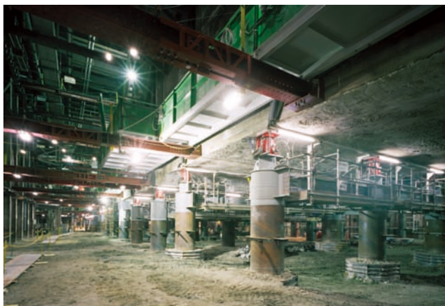
写真-2 仮受け状況
