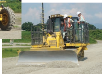
ブルドーザでの施工実習 ▶
