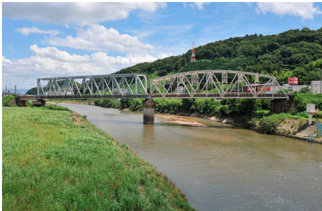
写真-2 第3大和川橋梁(下流から撮影)
