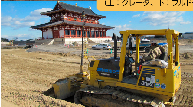
3次元マシンコントロールシステム (上：グレーダ、下：ブルドーザ)
