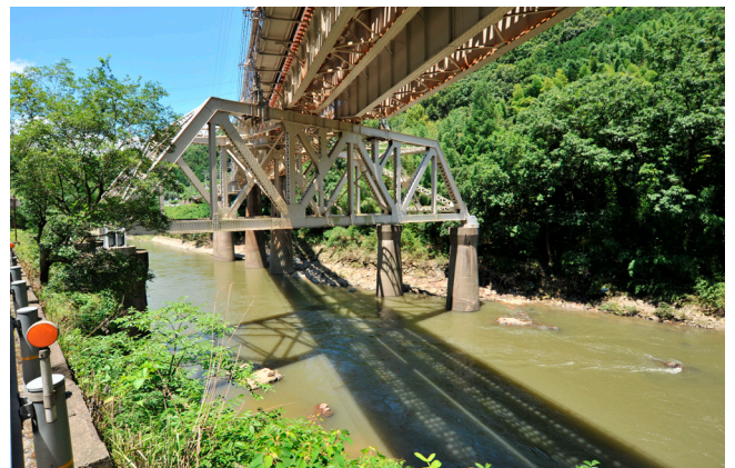
写真-4 第4大和川橋梁の橋脚配置(上流から撮影)
