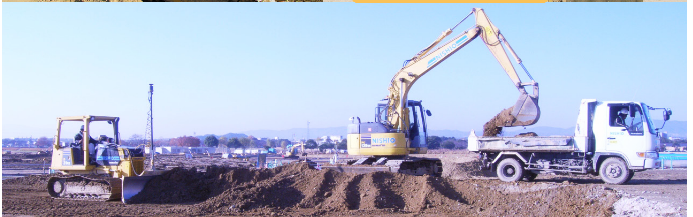
GPS自動追尾転圧管理システム
