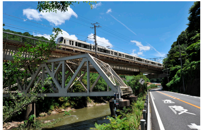
写真-3 第4大和川橋梁(下流から撮影)
