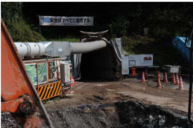
写真-2 7号排水トンネル坑
