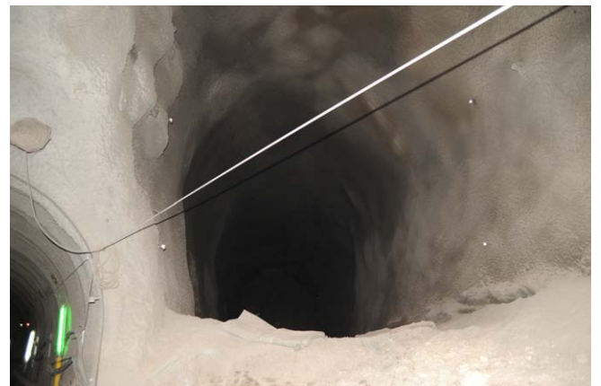
写真-3 排水トンネルと国鉄トンネルとの交差部
