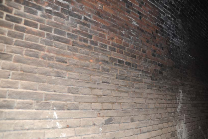
写真-5 国鉄トンネルの壁（レンガ色の残るレンガ）
