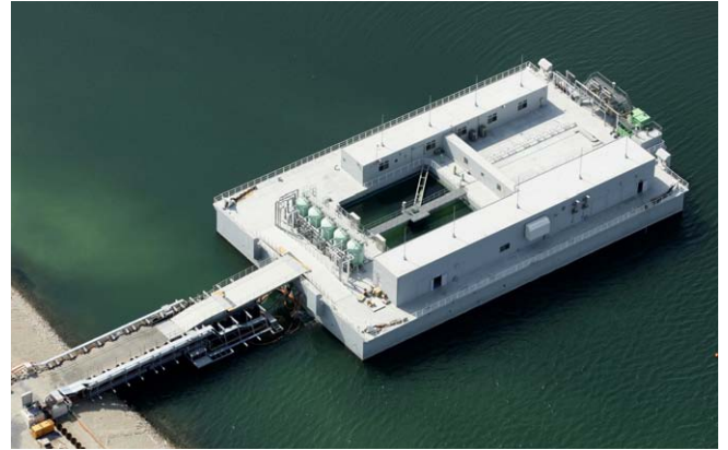
写真-4 排水処理施設
