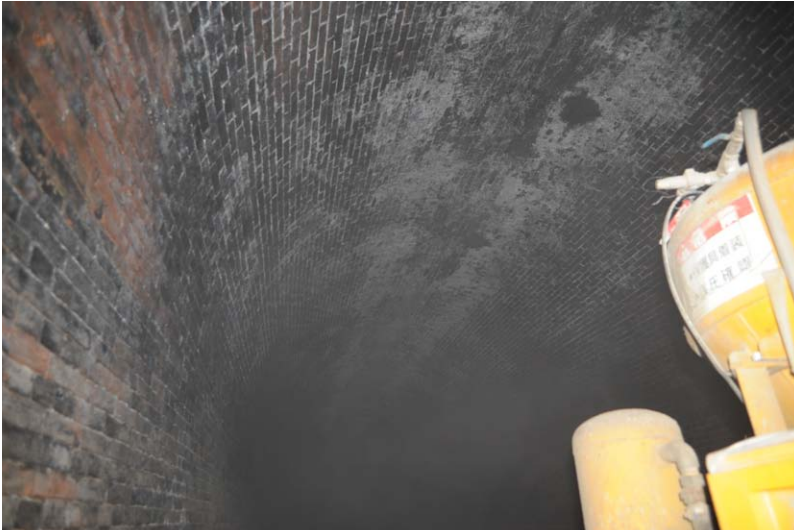
写真-4 国鉄トンネルの天井（煤けたレンガ）
