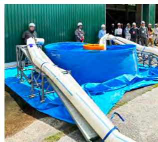
排水ポンプ作動実施
