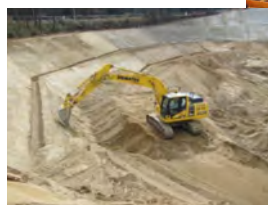
ICT建機を用いた切土工事の紹介
