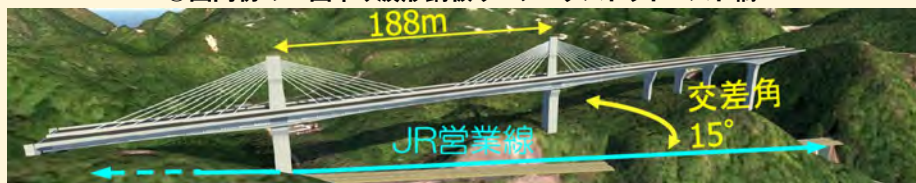
◎国内初の一面吊り波形鋼板ウェブエクストラードスト橋
