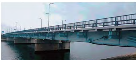
参考 外ケーブル補強（鋼桁）施工例
