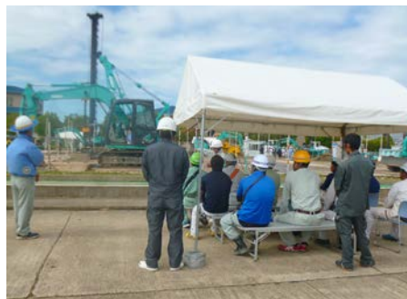
実地試験の全体説明風景
