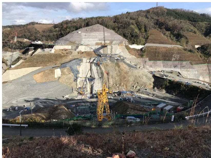
写真-1 安威川ダム工事現場
