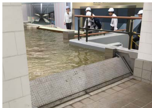
写真-1 可動防潮堤
