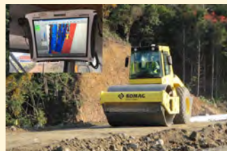
転圧管理システム
