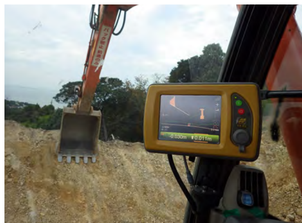
写真-6 切土作業状況
