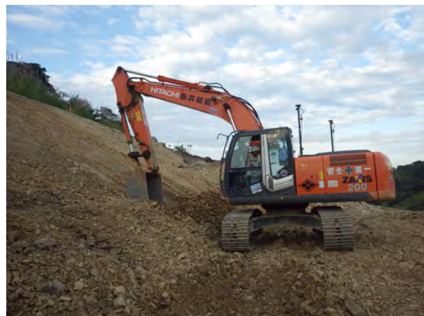
写真-5 切土作業状況
