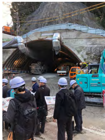
写真-1 施工現場
