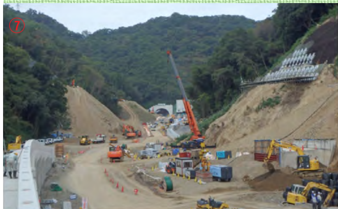
⑦ 平井ランプ部：法面工の整備を進めている。
