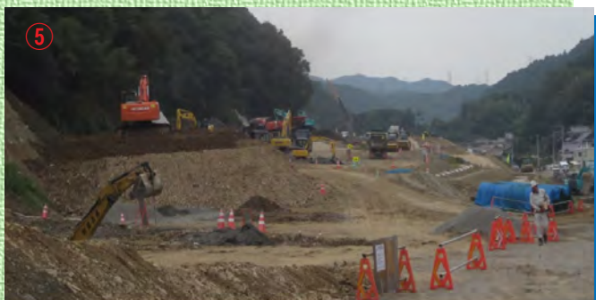
⑤ 中孝子：多くの重機を投入し、盛土工事が急ピッチで進められている。
