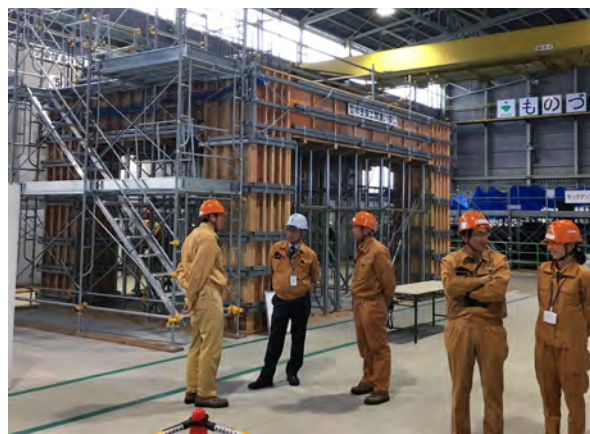
写真-3 足場の設置方法（間違い探し）
