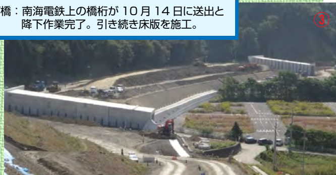
③ 下孝子地区：函渠工が9月に完成。盛土工事を進めている。
