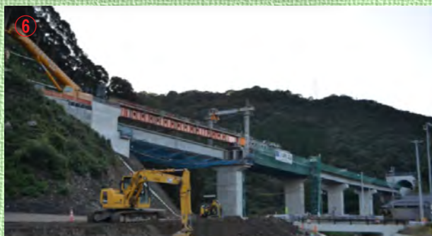
⑥ 上高子高架橋：最後の桁を架設し、完成に近づいている。
