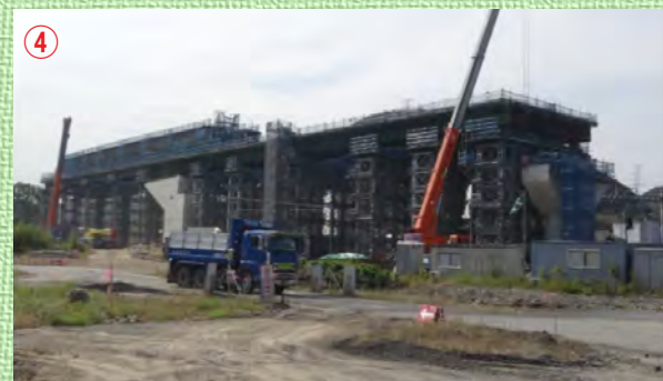
④ 孝子ランプ：南海電鉄上の橋桁を送り出す準備を行っている。
