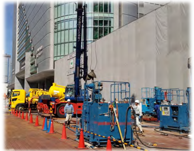
写真-6 地盤改良の施工状況
