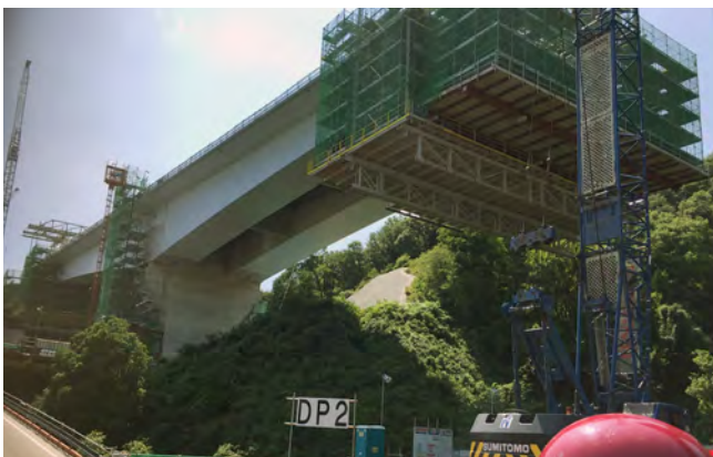
写真-2 片持架設用移動作業車（ワーゲン）
