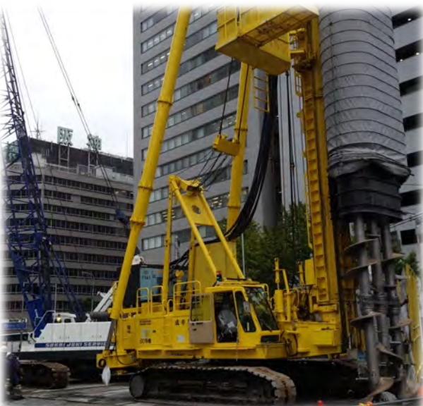
写真-5 土留工（SMW工法）の施工状況
