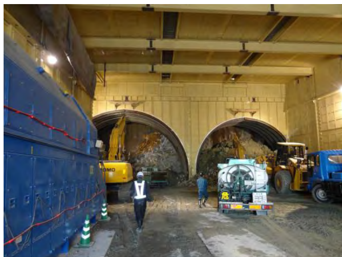
トンネルの変状計測
