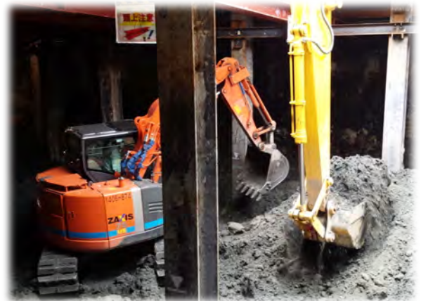
写真-7 路面覆工下での掘削状況
