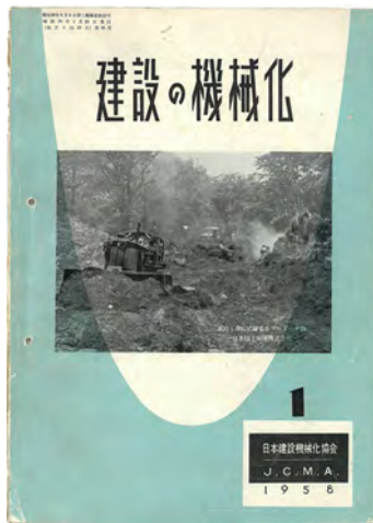
第 95 号表紙写真 日本国土開発株式会社施工 関西電力黒部第四発電所 大町ルート道路第三工区工事
