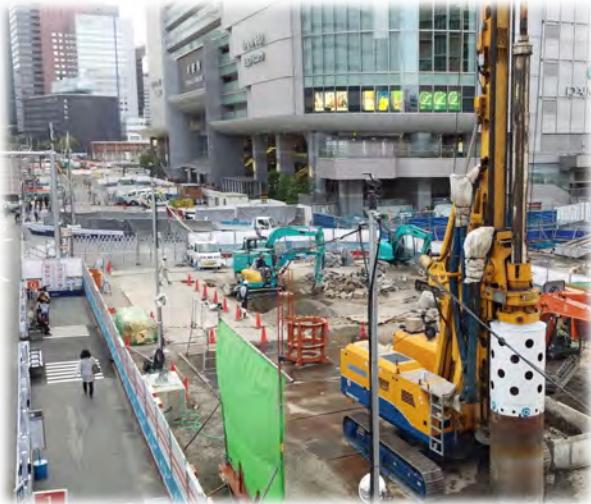
写真-4 BG工法での地中障害物撤去作業状況
