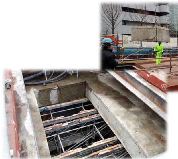
写真-3 既設躯体撤去の施工状況
