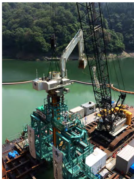
写真-2 水中作業機によるダム湖掘削
