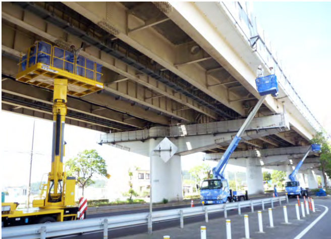
写真-1 橋梁点検状況 (トンネル点検車とリフト車併用)
