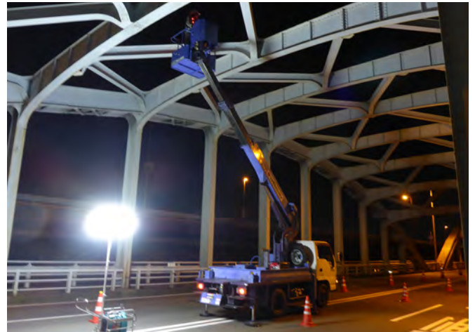
写真-2 橋梁点検状況 (リフト車使用)
