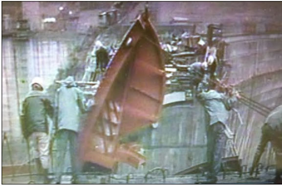
写真-10 クレストゲートの据付状況
