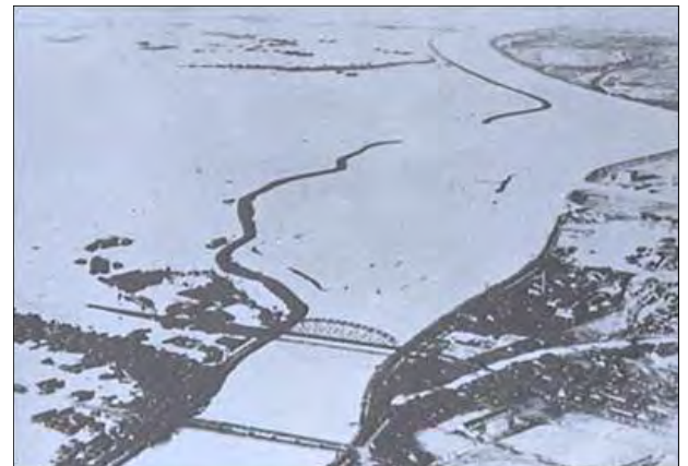
写真-3 宇治川の決壊（京都市伏見区向島付近）
