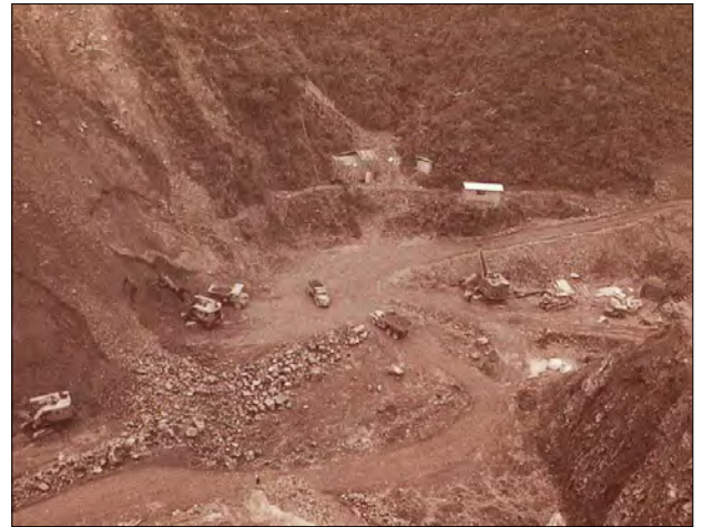
写真-7 ダム本体部の掘削状況
