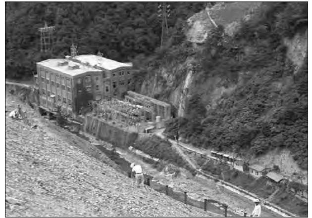
写真-2 志津川発電所
