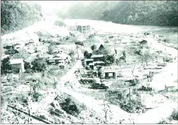
写真-4 移転中の大津市石山外畑町の集落
