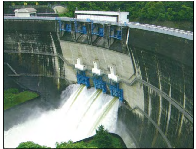
写真-13 放流中の天ヶ瀬ダム
