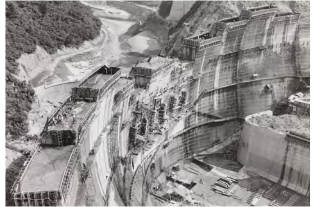
写真-8 ダム本体のコンクリート打設状況
