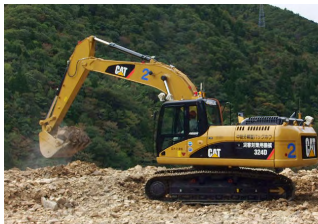
写真-7 組立完了したバックホウ
