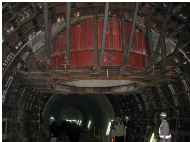
写真-1 上向きシールドによる立坑築造
