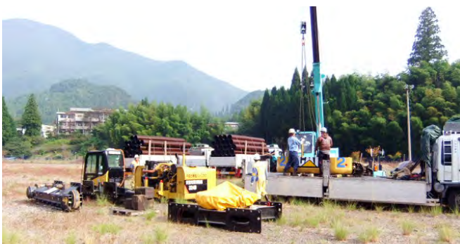
写真-4 ヘリポートに陸送された分解ブロック
