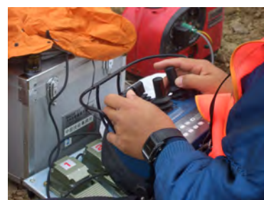
写真-8 遠隔操作による施工状況
