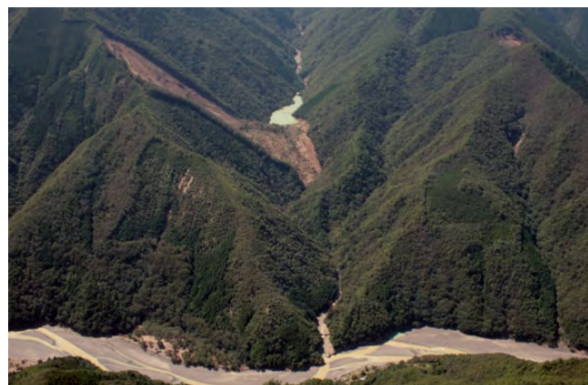
写真-1 長殿地区の被災状況
