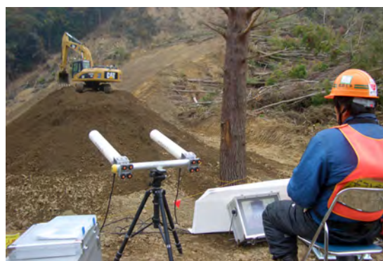
写真-8 遠隔操作による施工状況
