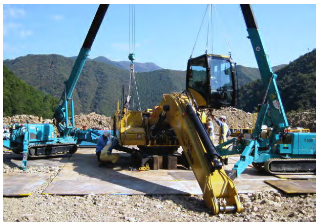
写真-6 現場での組立作業
