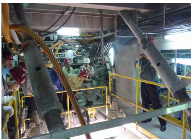
写真-3 シールドマシン内
