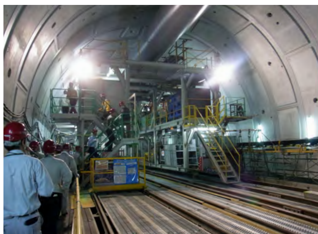
写真-2 シールド坑内
