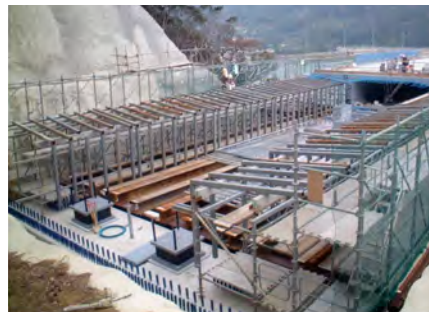
側径間支保工施工
