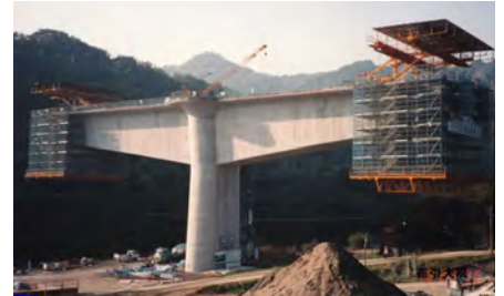
片持架設用移動作業車例
