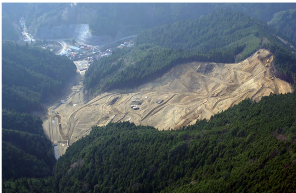
写真-8 施工状況(空撮)上流から
