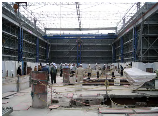
写真-5 ハット内部
