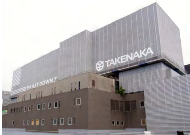
写真-6 ハット・低層階の解体
