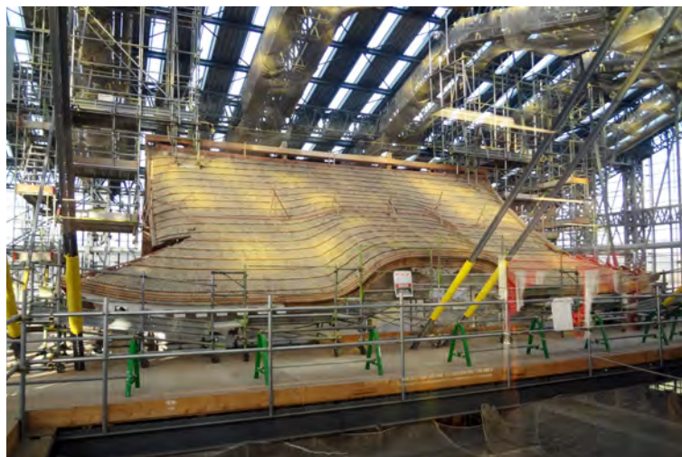
写真-4 保存修理中の屋根瓦
