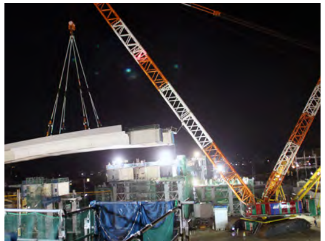
大山崎(1,250t吊クレーン架設工法)
