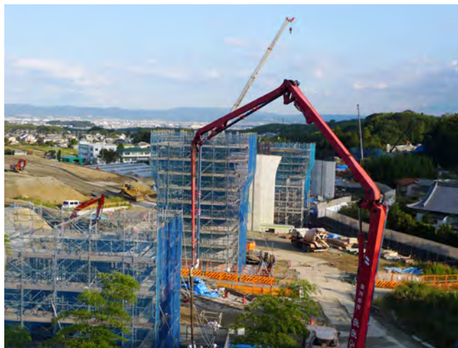
灰方高架橋(仮称)
