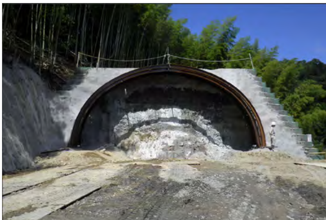
写真-1 西代トンネル坑口部
