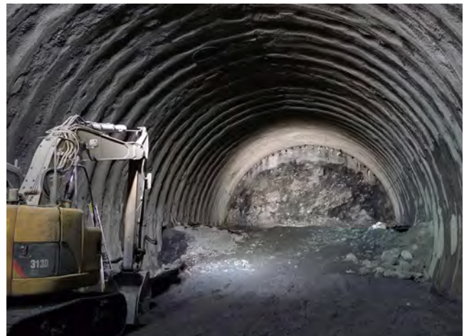
西山トンネル(仮称)(奥海印寺)
